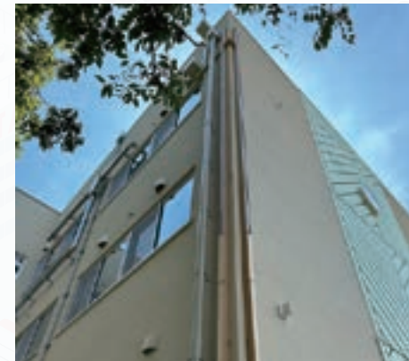
カーテンウォール部材設置状況
