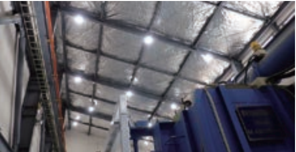
動風圧試験場 (はるクール施工後)
