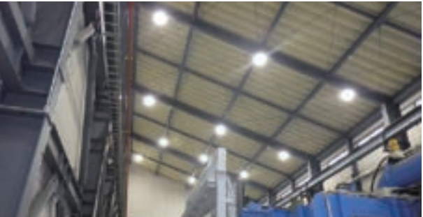
動風圧試験場 (はるクール施工前)
